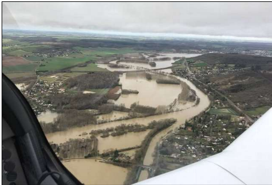
Inondation à Joigny en janvier 2018
